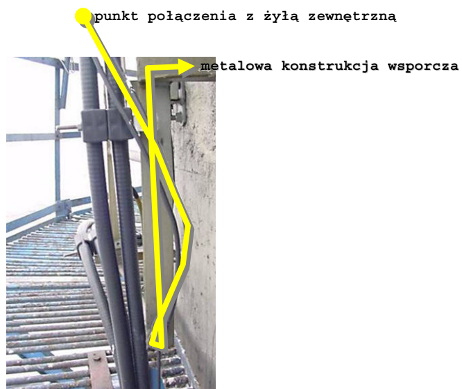
Rys. 8.12. Droga prądów wyrównawczych w pętli „ukrytej”
