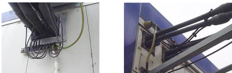
Rys. 8.8. Półpętla z linek wyrównujących potencjały żyły zewnętrznej kabla koncentrycznego
