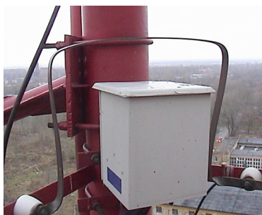
Rys. 8.7 Półpętla z przewodu taśmowego
