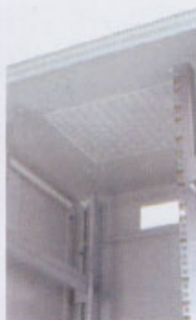
Duże otwory wentylacyjne (podłoga/dach)
