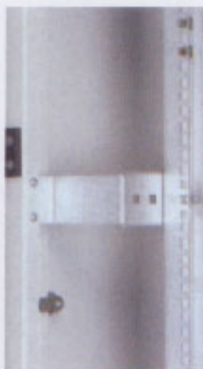
19" standard, profile z otworami śrubowymi o powtarzalnym rastrze
